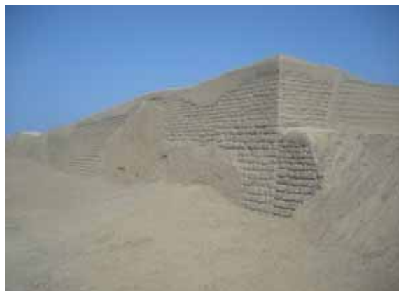
F- 02.- Esquina Nor este, vista desde el exterior del muro perimetral .
