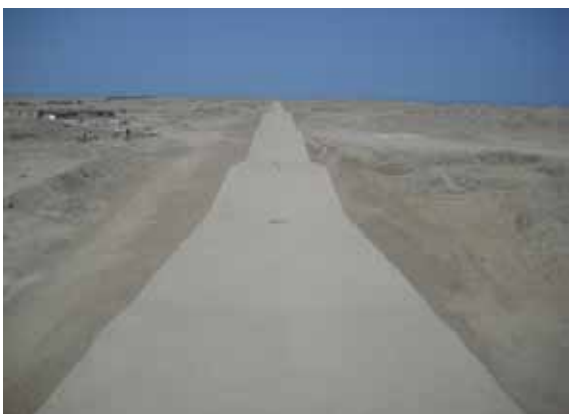
F-03.- Perspectiva de la eabecera del muro perimetral este.
