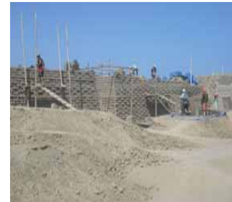
F- 06.- Trabajos de reestructuración en el muro perimetral este.
