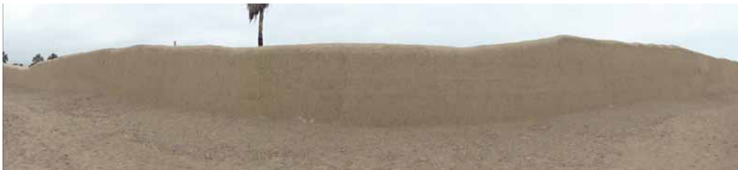
F- 01.- Muro perimtral este, paramento interno.
