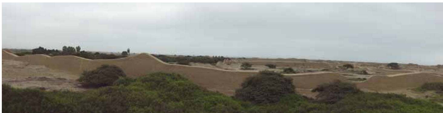
F- 02.- Muro perimtral norte, elevacion exterior.
