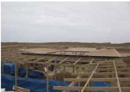
F- 03, F-04.- Proceso de intalacion de cubiertas en planchas de tecnoport sobre las estructuras de madera .
