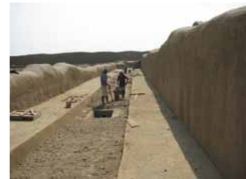
F- 06.- Trabajos de acabado en la instalacion de la rde de drenaje en el corredor.
