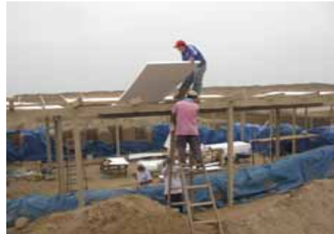
F- 03, F-04.- Proceso de intalacion de cubiertas en planchas de tecnoport sobre las estructuras de madera .
