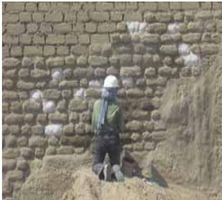
F- 04- Tratamiento de sectores con adobe arqueológico para combatir la acción del salitre.
