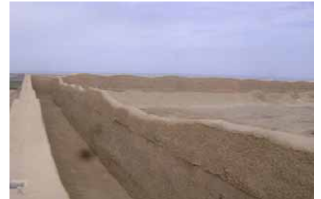
F- 07 .- Vista panorámica de Este a Oeste del paramento interior terminado ddel MP Sur. Apréciese también las cabeceras terminadas del MP Este.
