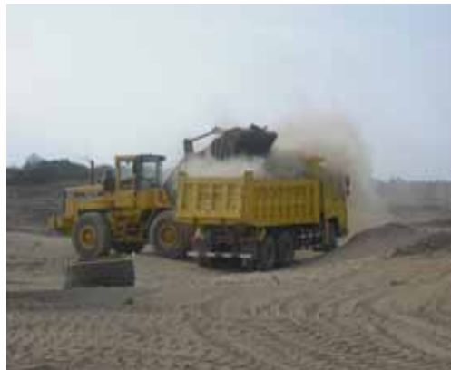
F- 05.- Eliminación de material proveniente de los escombros de liberación , salitrado y suelo estéril.
