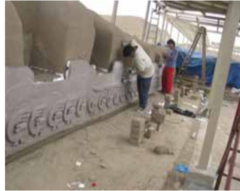
F- 01, F-02.- Trabajos de Instalacion de replicas en fibra de vidrio de relives en las audiencias del sector central.
