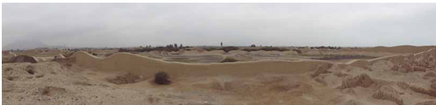
F- 03.- Muro perimtral este, elevacion interior, sector sur.
