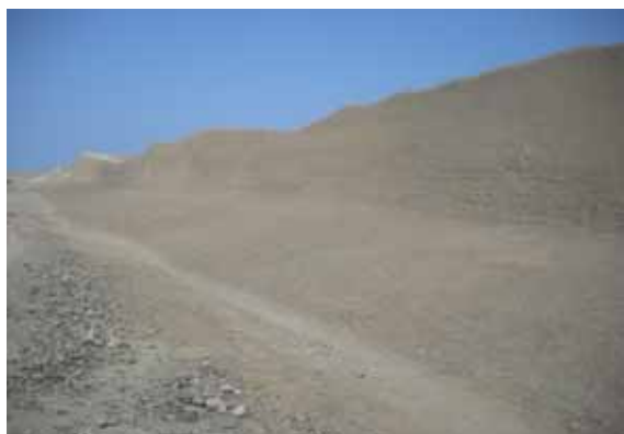
F-01.- Perspectiva de la esquina Sur Este desde el paramento exterior del muro este.
