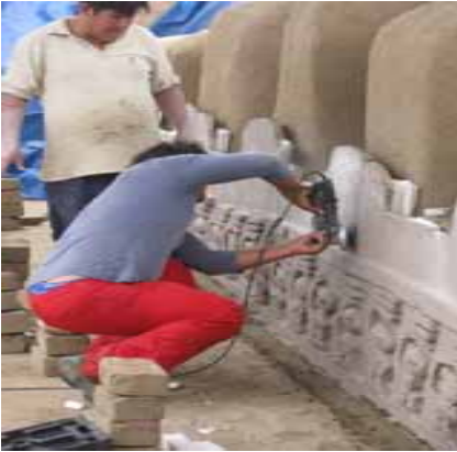
F- 01, F-02.- Trabajos de Instalacion de replicas en fibra de vidrio de relives en las audiencias del sector central.
