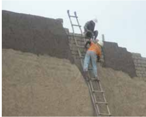
F- 02- Emporrado del paramento externo del muro perimetral este a la altura de las cabecera.
