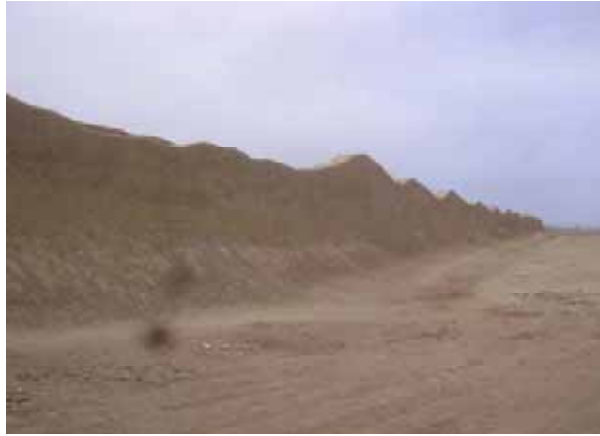
F-02.- Vista panorámica frontal de Norte a Sur del muro perimetral Oeste paramento externo.
