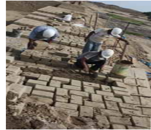
F- 05.- Reestructuracion , disposicion d e las hiladas con adobe producido en obra en el muro perimetral oeste.
