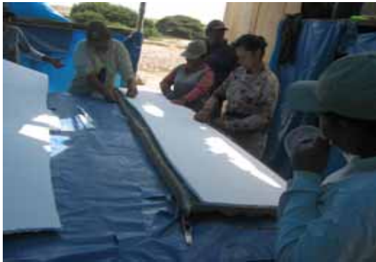
F- 03, F-04.- Trabajos para la instalacion de las replicas de fibra de vidrio, instalacion e tecnoport y presentacion modular.
