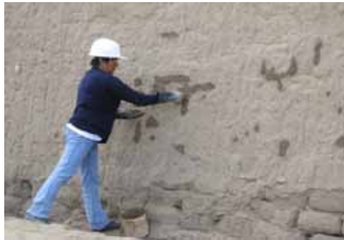
F- 02.- Resane y de orificios en te enlucido del paramento del muro perimetral oeste .
