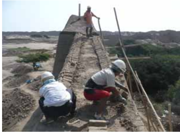
F- 02 .- Tratamiento de cabeceras en el muro perimetral norte , definicion de encausamientos para el drenaje de agua pluvial en el muro perimetral norte.
