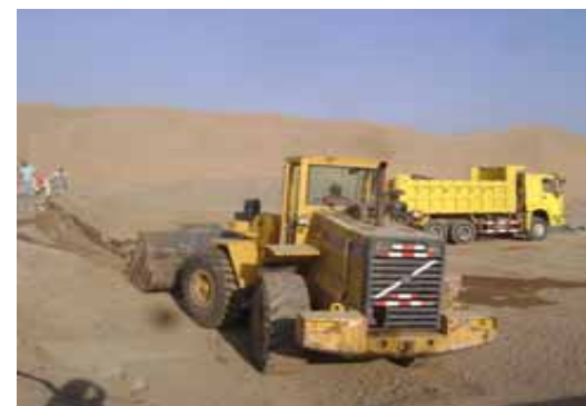
F- 06 .- Eliminacion del material salitrado en grandes volumenes del sector externo oeste : cargío y traslado mecanico.
