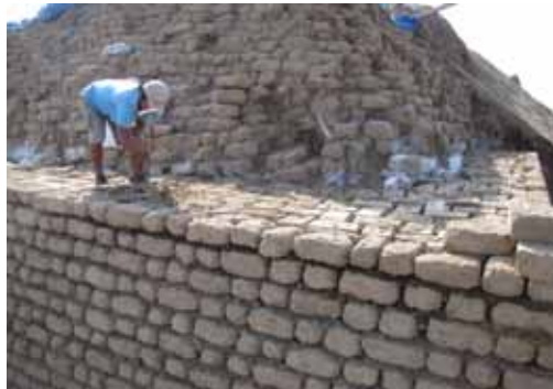
F- 04.- Reestructuración de colapsos y precolapsos en el muro perimetral oeste.
