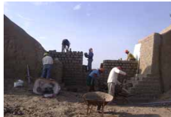
F- 05.- Trabajos de clausura del acceso norte para dar seguridad al sector interno del Conjunto Amurallado Chol An.
