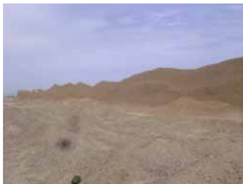
F- 04.- Iparamento externo del muro perimetral este - sector sur.
