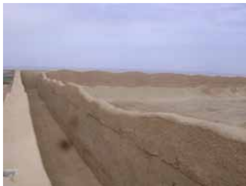
F-02.- Perspectiva final del muro perimetral exterior este - sector de la esquina sur este.
