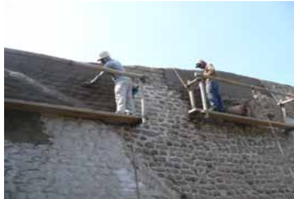
F- 04 .- Tarrajeo y emporrados en el paramento exteriorr del muro perimetral este.
