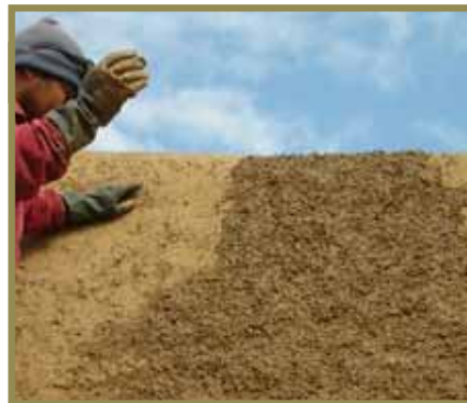
F- 03, F- 04.- Tarrajeo y emporrado de los pàrmentos del muro perimetral este del Conjunto Amurallado Ñing An.
