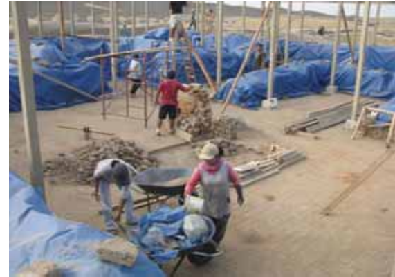
F- 05, F - 06 .- Proteccion de los relieves originales durante la instalacion de las estructuras de las coberturas.
