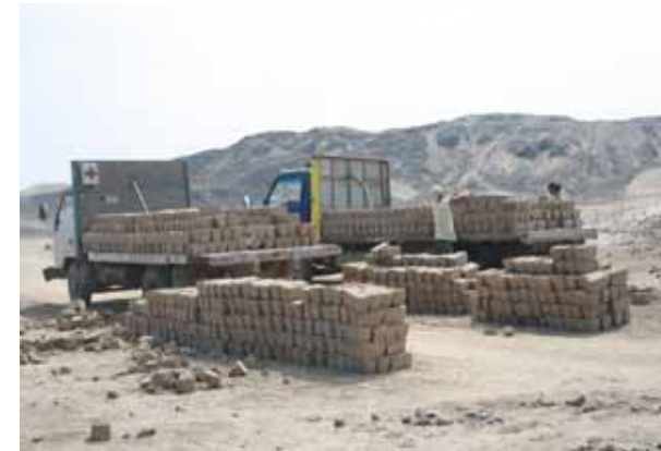
F- 06 .- Transporte mecanico de adobe troncopiramidal producio en obra desde la planta norte de adobes hasta los puntos de intervencion en reestructuracion y calzadura.
