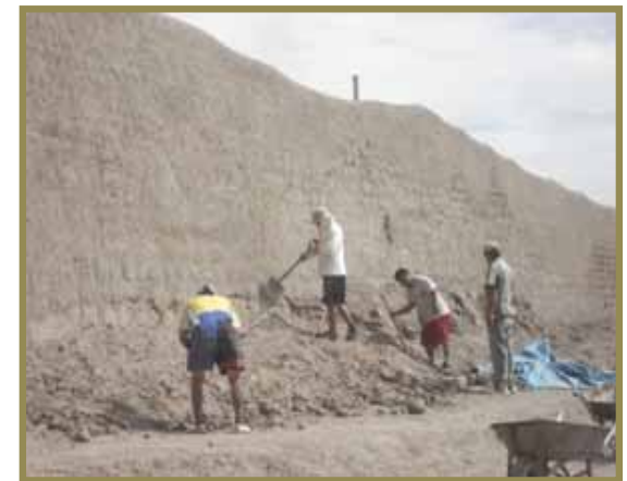
F-05.- Proteccion basal del muro perimetral este del Conjunto Amurallado Ñing An.
