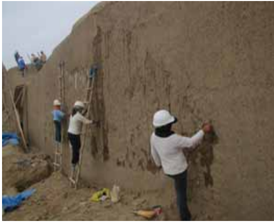
F- 01.- Resane y consolidacion de enlucidos expuestos a traves de las excavaciones arqueologicas.
