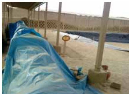
F- 04.- Muro protegido con la manta plastica.
