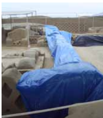
F- 01.- Extendido de las mantas plasticas
