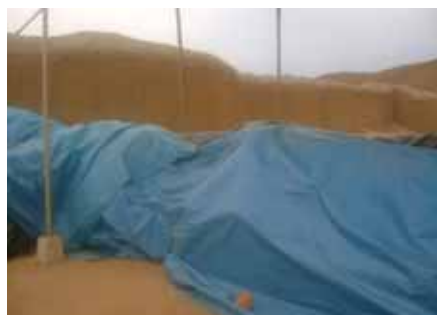
F- 03.- Fijacion de las mantas empleando ladrillos de arcilla quemada.
